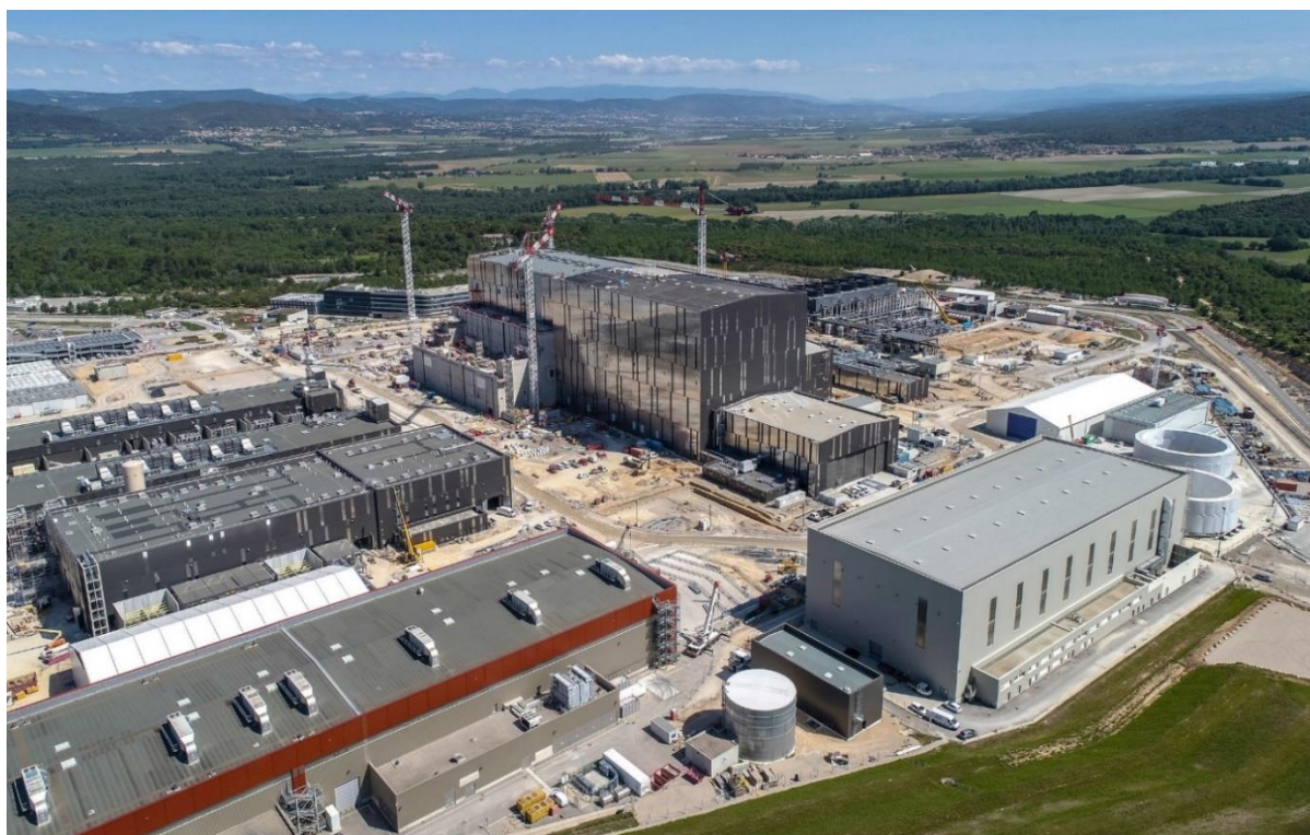
1.1. ábra Az ITER főépületének építési területe (www.iter.org, 2020)
